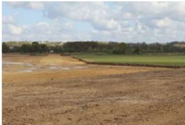
Illustration 7: Décapage d'une prairie et de son sol avant exploitation GPEA)
